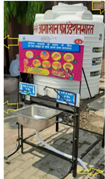
الشكل 17: محطة غسل يدين تعمل بدواسة القدم مع خزان ضخ. حقوق الصورة: مؤسسة آغا خان، الهند
