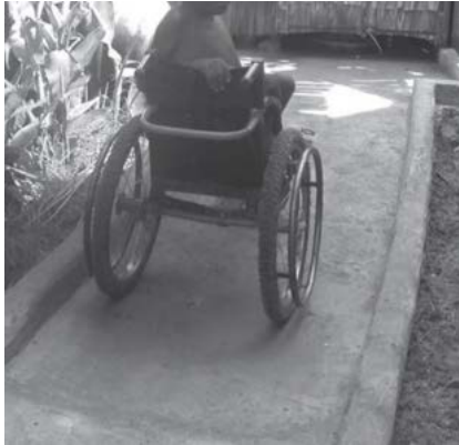
الشكل 2: مسار أسمنتي واسع مع حواف ناتئة. حقوق الصورة: Jones and Reed (2005)
