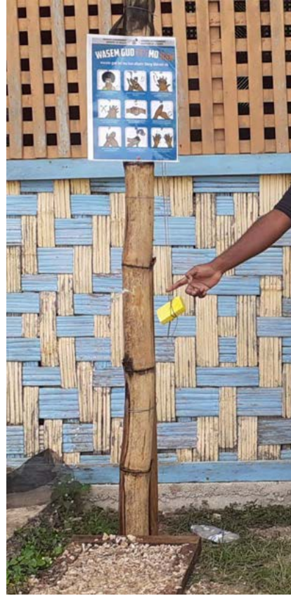
الشكل 16: محطة غسل اليدين مكتملة مصنوعة من الخيزران حقوق الصورة: مؤسسة الرؤيا العالمية الدولية - فانواتو
