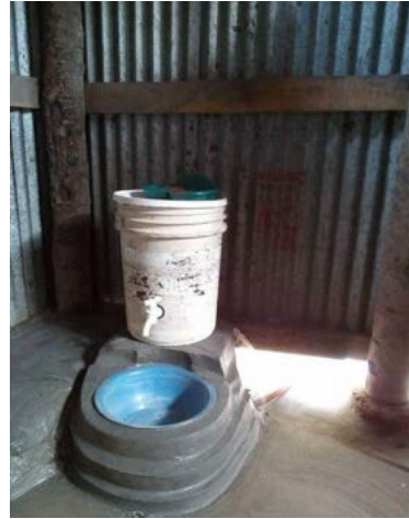
استخدام حاويات الدهان مع حنفية، يتم تركيبها داخل المطبخ إلى جانب وعاء بلاستيكي كحوض
