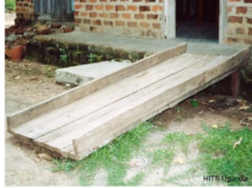
الشكل 4: منحدر خشبي مؤقت/متنقل. حقوق الصورة: جونز و ويلبور (2014)
