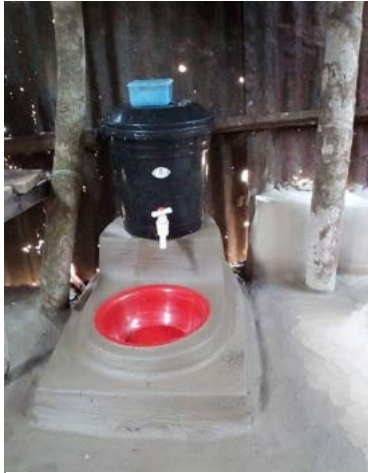
لو مع حنفية، يتم تركيبه داخل المطبخ إلى جانب وعاء بلاستيكي كحوض
