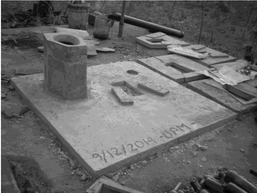
Figure 5.5 Dalle pour personnes avec ou sans handicap, Kongwa, Tanzanie
