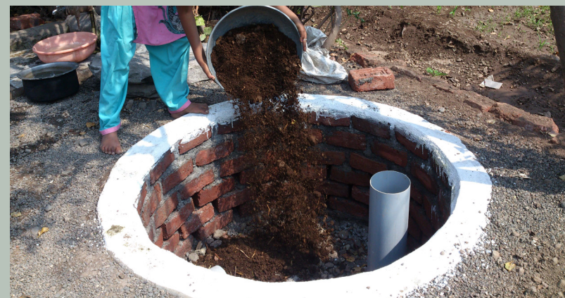
« Toilette tigre » en cours d'installation en Inde. Photo : Claire Furlong.
