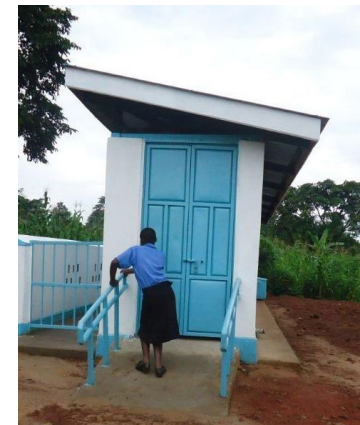
Complexo sanitário com uma casa de banho específica com corrimões e acesso nivelado. Foto: Plan International
