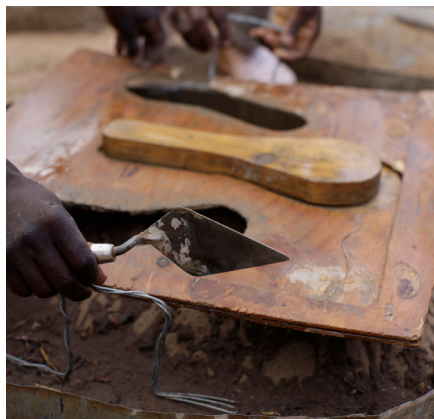
Promotores fazendo uma placa para o chão de uma latrina, aldeia de Chikompulazi, Mzuzu, Malawi. Fotografia: WaterAid/Layton Thompson
