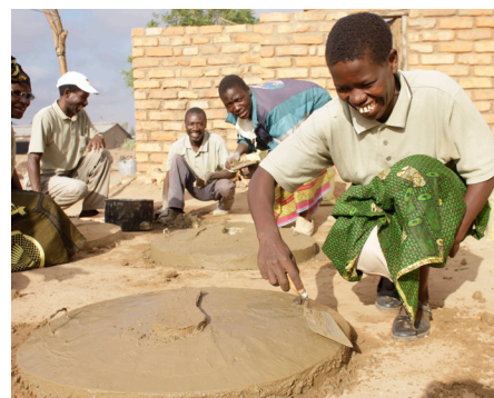
Elifa Mwaungulu en train de construire une dalle de latrine dans le village de Chikomplazi, Mzuzu, Malawi. Photo : WaterAid/Layton Thompson.
