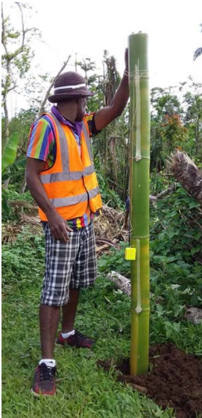
Figura 15: Um novo ponto de lavagem das mãos de bambu a ser enterrado no chão. Foto: Visão Mundial Internacional - Vanuatu
