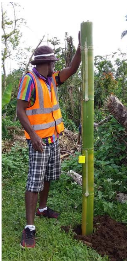
Figure 9 : Nouveau poste de lavage des mains en bambou inséré dans le sol. Photo : World Vision international – Vanuatu
