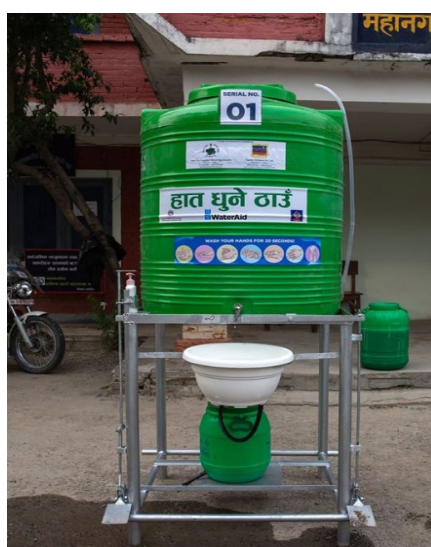
Figure 18 : poste de lavage des mains à pédale avec citerne. Crédit : WaterAid Népal
