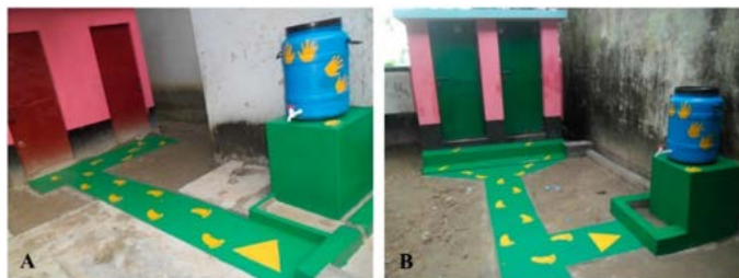
Figure 8 : Installations de lavage des mains avec coups de pouce. Crédit : Dreibelbis R. et al. (2016) https://doi.org/10.3390/ijerph13010129
