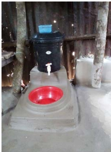
Seau doté d'un robinet, installé dans la cuisine avec une bassine en plastique en guise de lavabo
