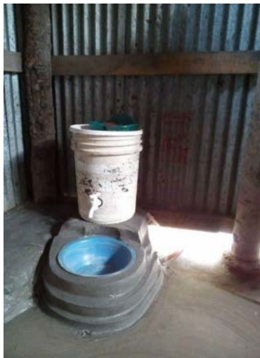
Pot de peinture usagé doté d'un robinet et installé dans la cuisine avec une bassine en plastique en guise de lavabo
