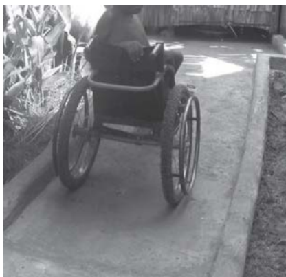
Figure 3 : Large chemin en ciment avec des bords surélevés. Photo : Jones et Reed (2005)
