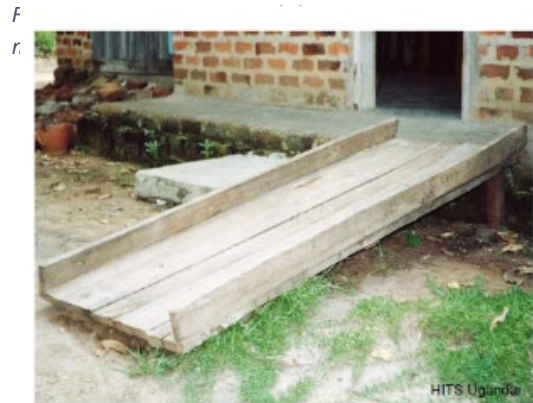
Figure 4 : Une rampe en bois provisoire/amovible. Photo : Jones et Wilbur (2014)
