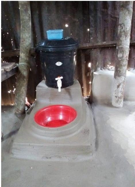
*Balde com torneira, instalado na cozinha juntamente com bacia de plástico*
