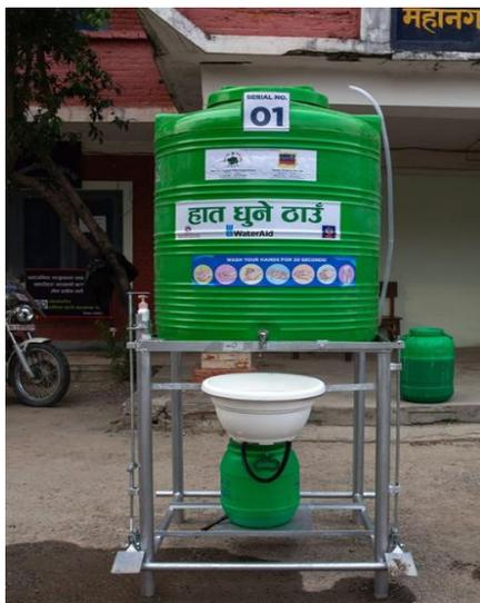
*Figura 10: Ponto de lavagem das mãos accionado a pedal com um grande depósito de água. Foto: WaterAid Nepal*
