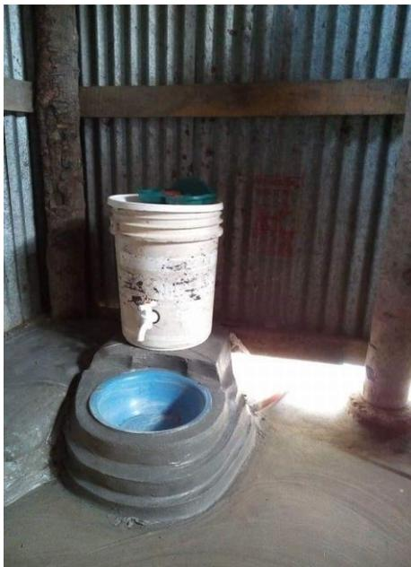
*Balde de tinta usado com torneira e instalado na cozinha juntamente com bacia de plástico*
