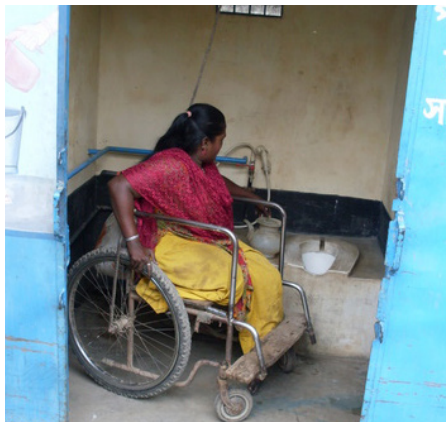
Casa de banho construída para pessoas com deficiência em Daca, Bangladeixe. Foto: Juliet Willets
