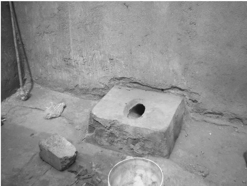
Figure 5.3 Traditional pour flush toilet
