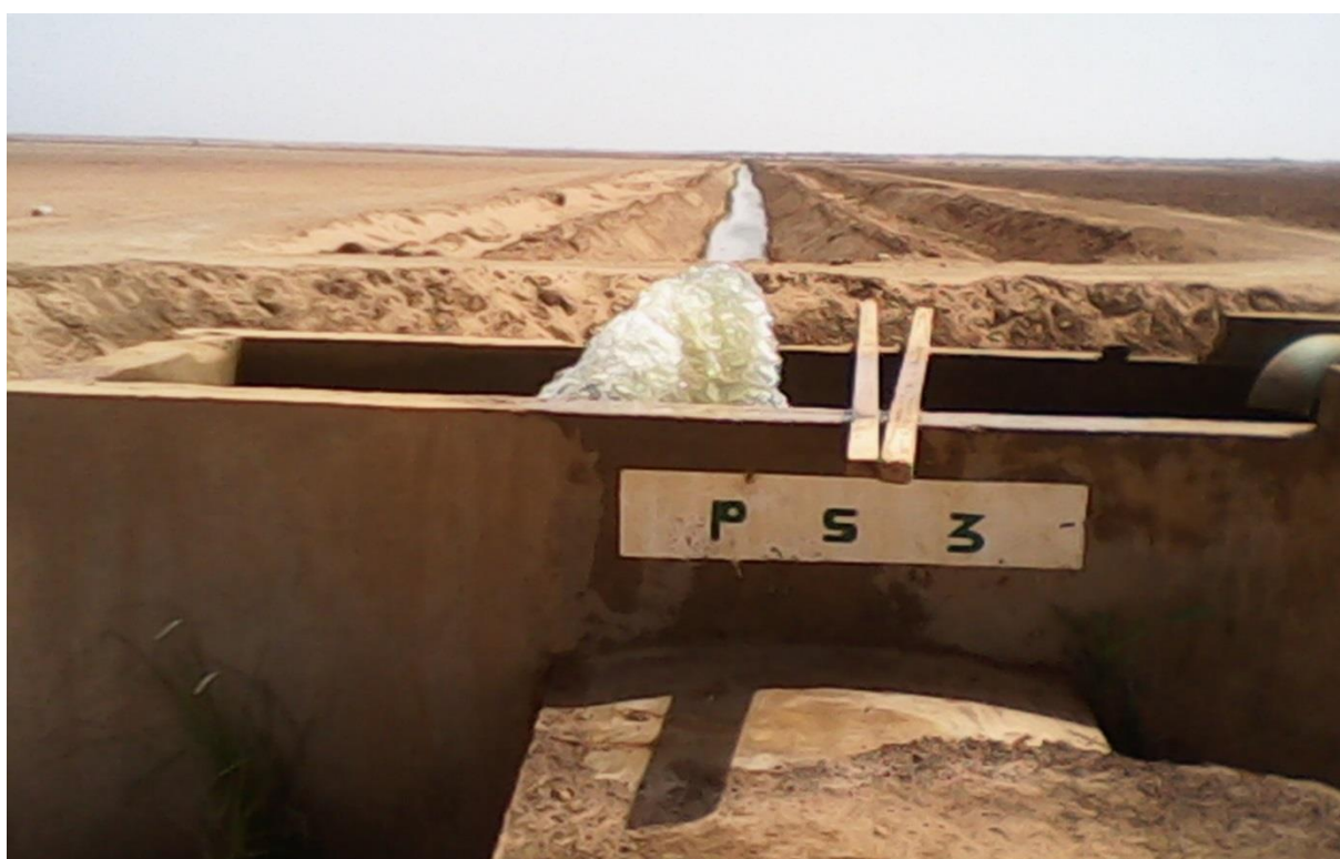
Photo 5: Canal PS3 servant d'alimenter les exploitations de Senhuile autour des villages de Ndiourki 1, Ndiourki 2 et Ndiougoudou
