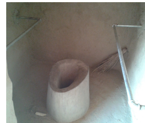
Sanita fixa com corrimões. Os corrimões poderiam ser feitos de madeira para reduzir o custo. Foto: WaterAid/Jane Wilbur.
